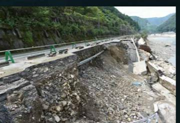
濁流によって護岸が削られ、道路が何カ所も崩落した(写真提供:西日本建設新聞)
